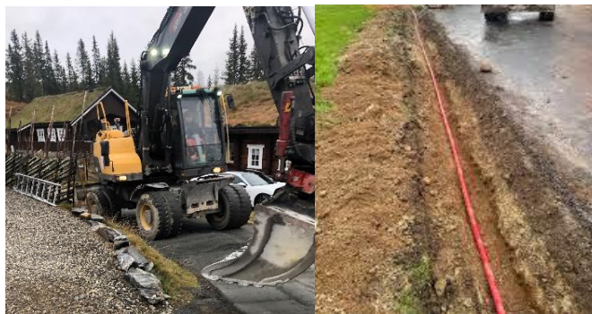
Fiber fra Eidsiva Breiband ble installert høsten 2022
