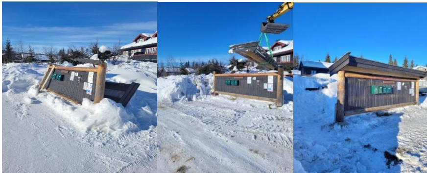
Vinden med kuling i kastene blåste ned postkassestativet i Hyttegrenda. Det ble raskt reparert.
