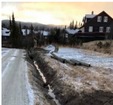
Utbedring av grøft og ny, større stikkledning langs Engemyraveien forbi postkassestativet
