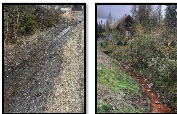
Utbedring av grøfter og ny, større stikkledning ved parkeringsplassen
