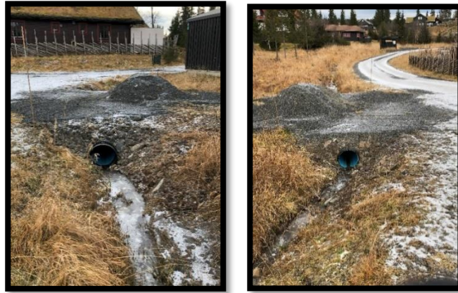
Stikkledning som ble oppgradert til 40 cm i slutten av oktober 2024
